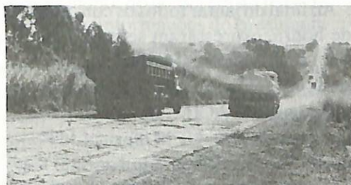
A falta de preservação das rodovias do Paraná dificulta o escoamento de produtos agrícolas para outros Estados
