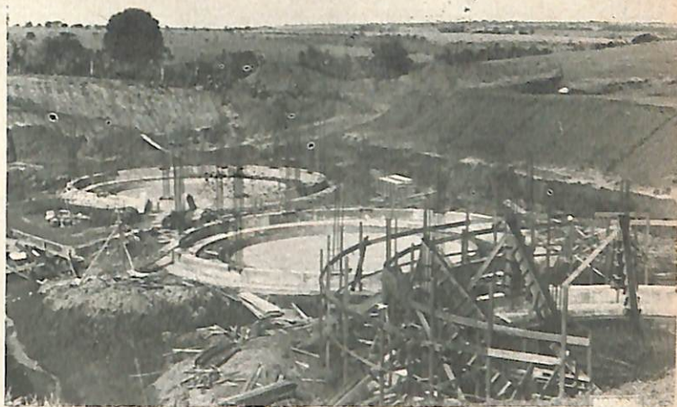
Execução de obras de saneamento
