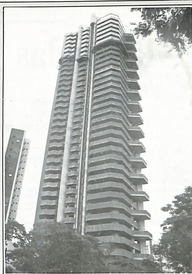
O Royal Garden, em fase de acabamento, será um dos mais belos e sofisticados edifícios do Paraná
