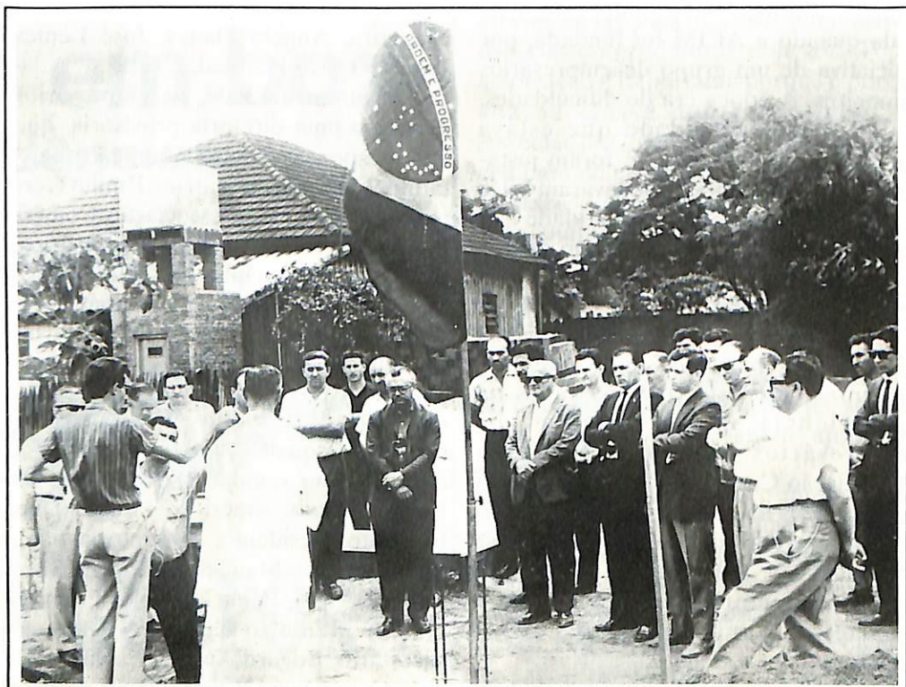
Lançamento da pedra fundamental da sede da ACIM, na década de 60
