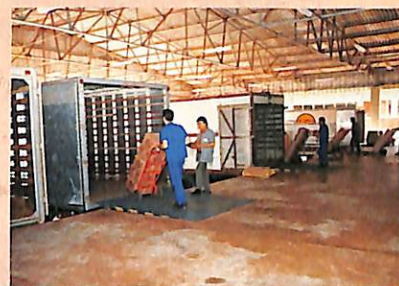
Central de carga/descarga de última geração
