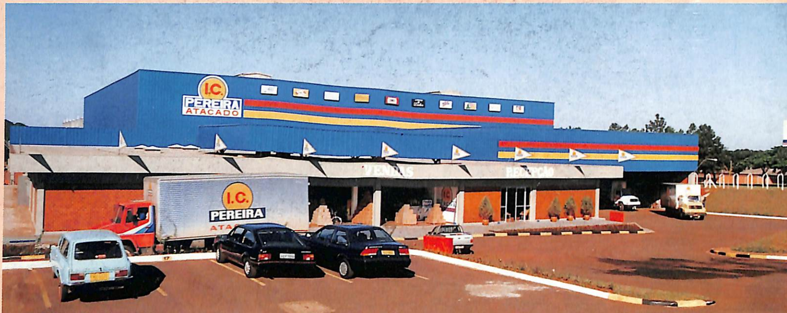
Vista parcial da fachada da nova loja
