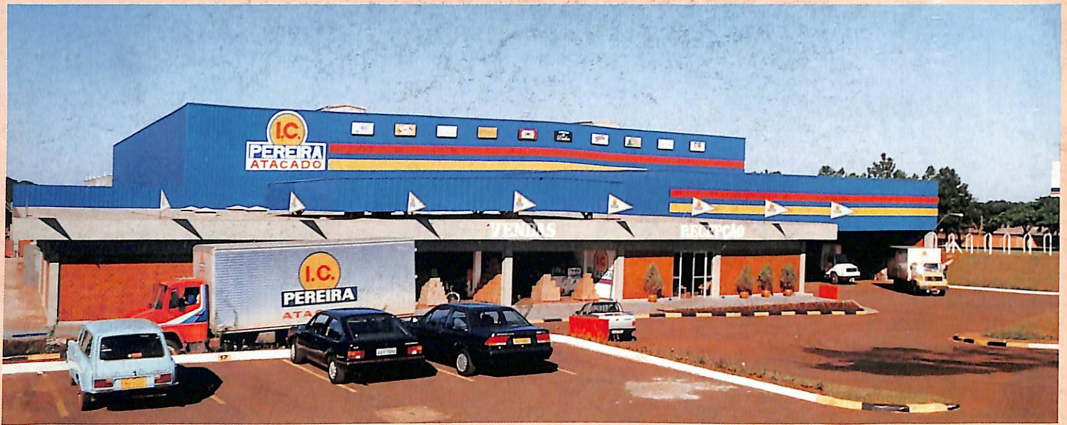
Vista parcial da fachada da nova loja
