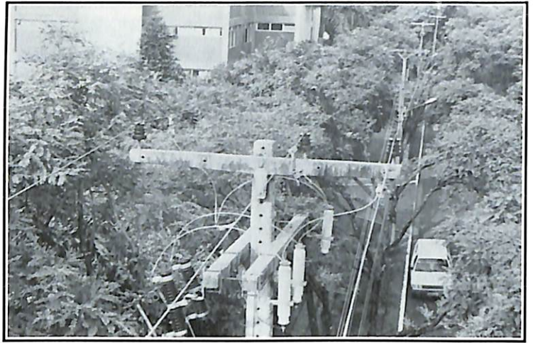
Aos poucos, a rede compacta vai substituindo o sistema tradicional em Maringá
