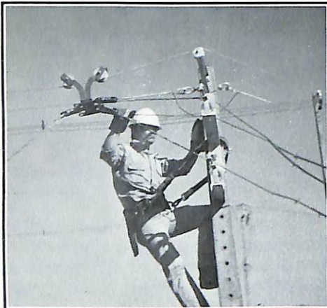
Técnico da Copel instala a rede compacta
