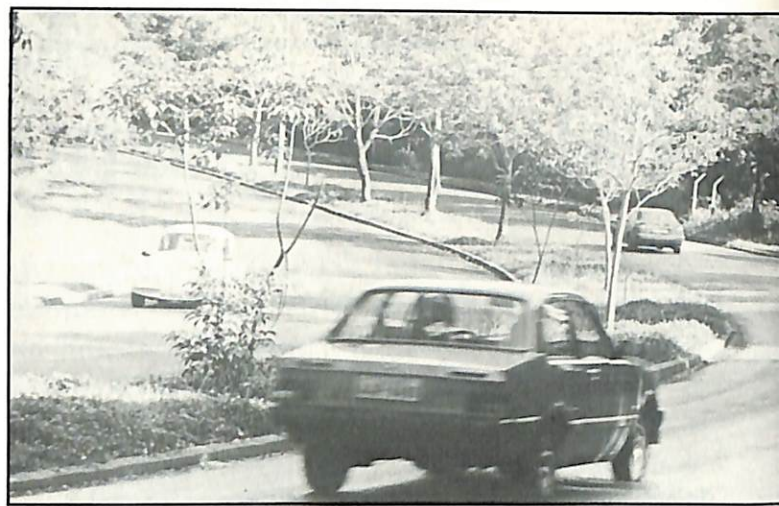
Recapeamento na avenida Juscelino K. de Oliveira
