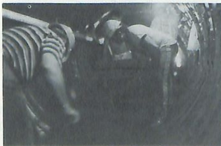
O Tunnel Liner possui 1.500 metros de extensão
