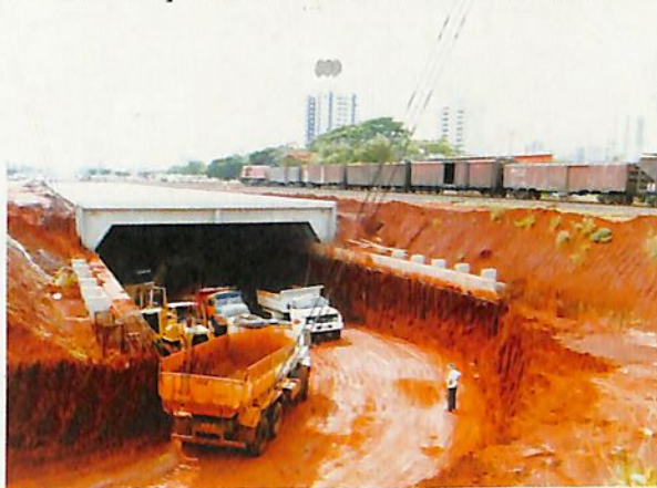
1.200 metros para 3 linhas: maior túnel ferroviário do Sul do Brasil
