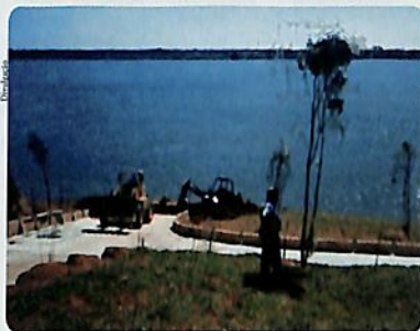
Condomínio terá parte das obras de infra-estrutura concluídas até dezembro
