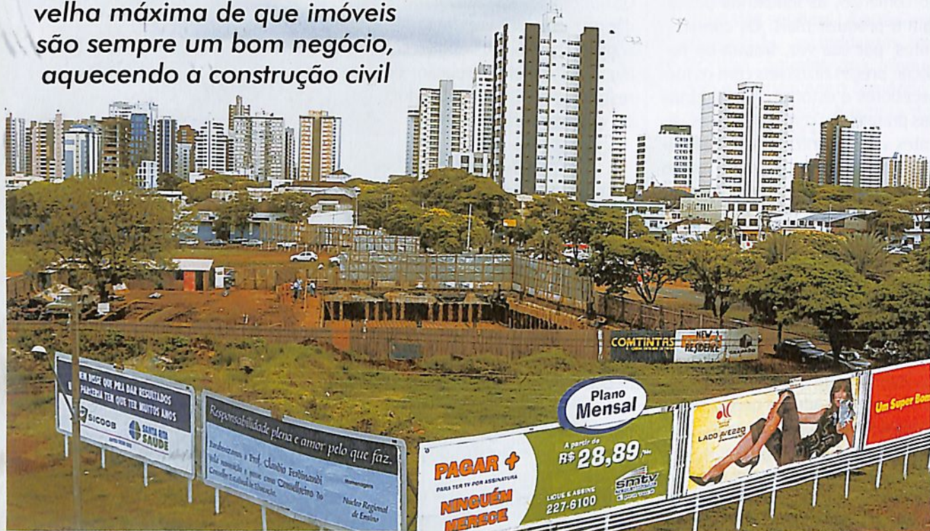
Obras já estão mudando paisagem do Novo Centro
