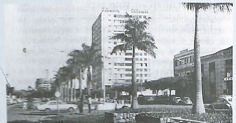
À esquerda, na esquina com a rua Santos Dumont, o Banco Brasul de São Paulo S.A; ao fundo, o Edifício Maria Teresa
